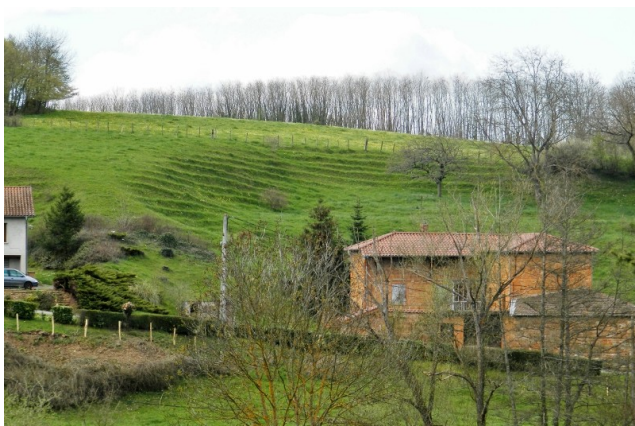
Glissement de terrain à l'amont du chemin du Moulin.
