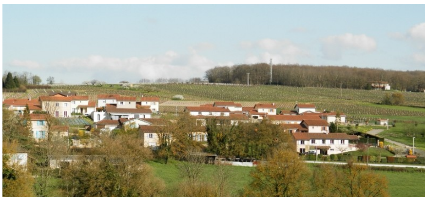
Vue générale du versant est, à l'amont du lotissement Le Fromental, exposé au ruissellement du fait notamment de l'exploitation viticole.
