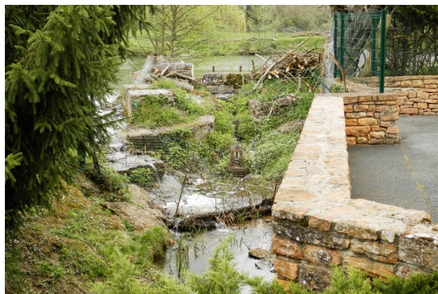
L'exutoire des étangs au niveau du Vieux Moulin est fortement encombré, augmentant le risque d'embâcle. Le parking du restaurant en rive gauche est exposé.
