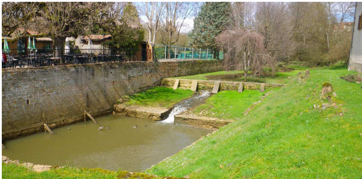
Seuils sur le Ruisseau du Moulin
