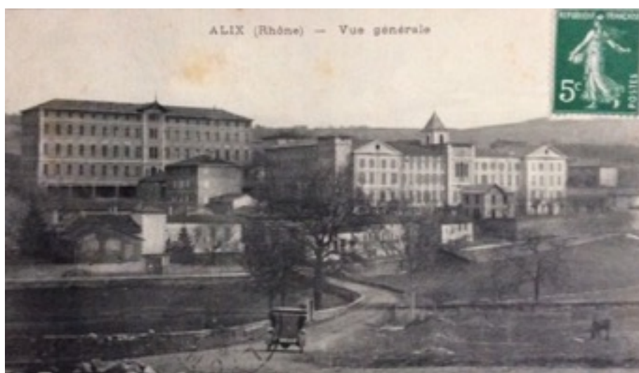
Le sanatorium pendant la construction de l'annexe
