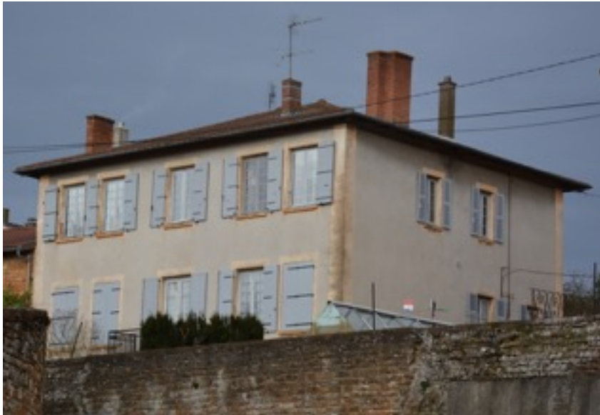
La maison construite pour Mme de l'Escalopier
